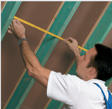
Fig. 1 Meet de ruimte tussen 2 kepers en voeg hier 1 à 2 cm aan toe. Mesurez la distance entre 2 chevrons et ajoutez-y 1 à 2 cm.
