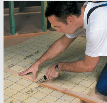
Fig. 2 Snij de gewenste breedte langs de maatstrepen af met een lat en het Isover isolatiemes. A l'aide du couteau Isover coupe laine et d'une latte, coupez à dimension en suivant les prémarquages.
